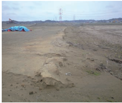
雨により法面の崩壊が起こりやすい
