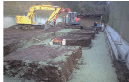
施工写真 (千葉県立佐倉高校雨水貯留浸透施設)
