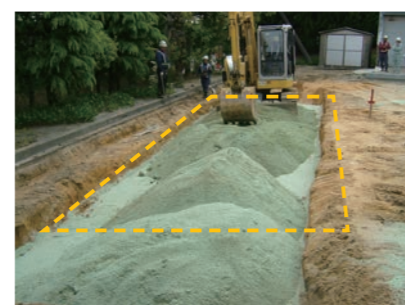
施工写真 (愛知県東浦町役場駐車場)
